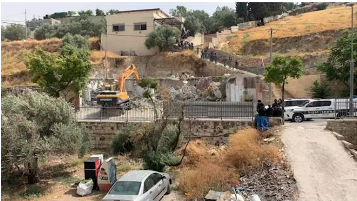
Ilustración 5: Excavadora israelí demoliendo una casa palestina. BTSELEM (EUROPA PRESS)
